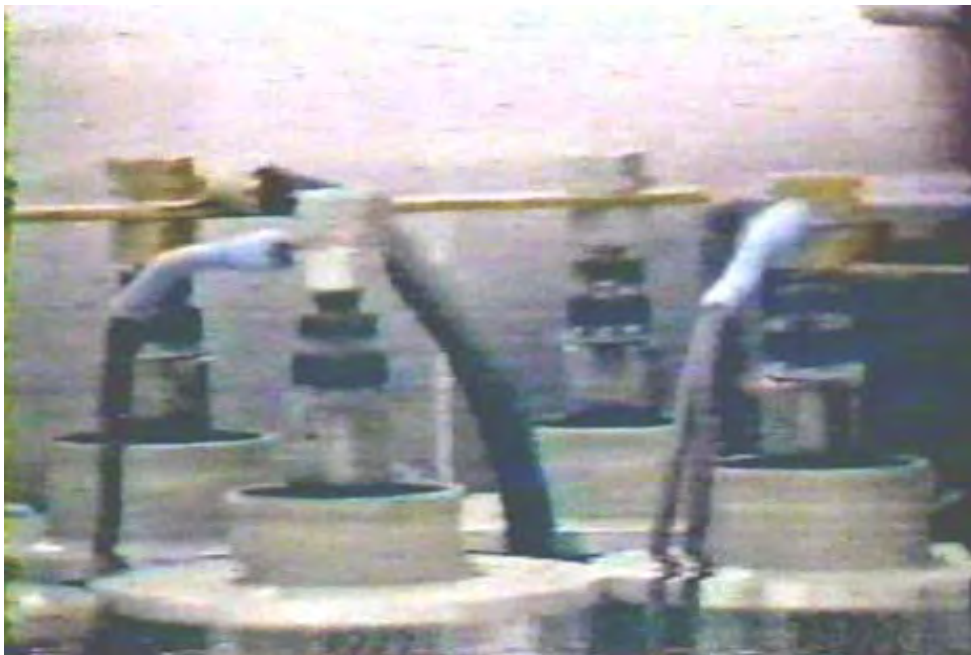
Ignitrons auf der "Red Motorwagen" installiert
